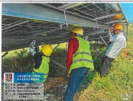
西沟区域 4#地块支架组件消缺
