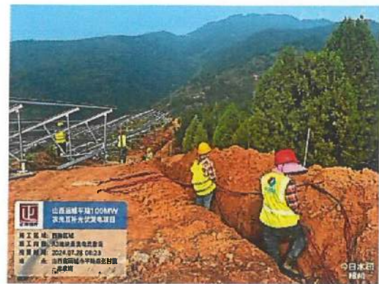
西沟区域直流电缆敷设
