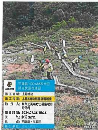
上苏区域桩基础砼浇筑
