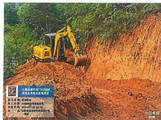
西沟区域 A4 地块进场道路修筑
