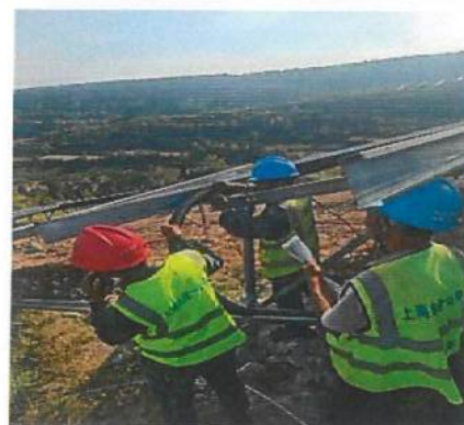
东郑增补地块直流电缆敷设
