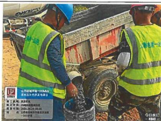
洪池 29 地块桩基础浇筑
