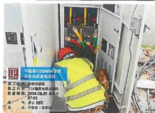
阳朝区域 23 地块箱变侧电缆头制作
