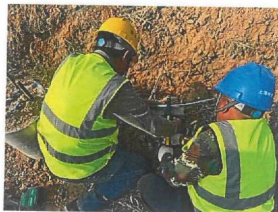
洪池 32 地块环网接地圆钢压接
