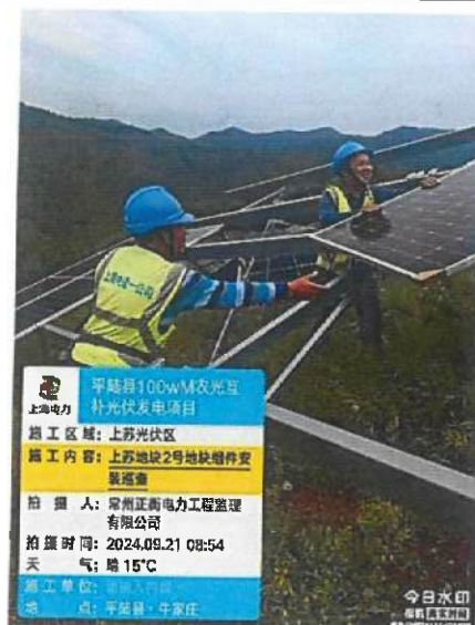
上苏 3 号地块组件安装
