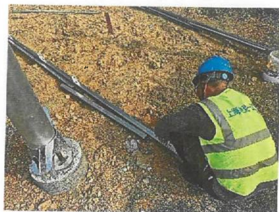
洪池 32 地块支架安装
