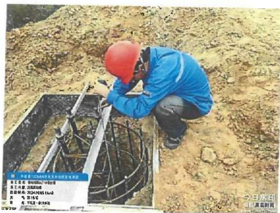
集电线路 AZ10 塔基础钢筋模板验收
