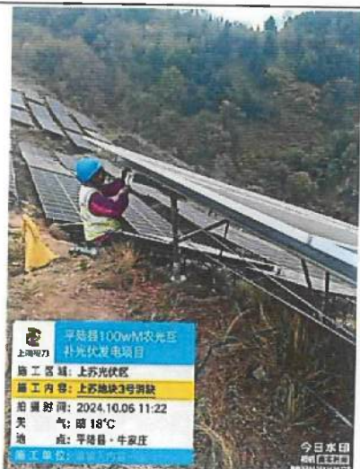
上苏地块支架组件消缺整改
