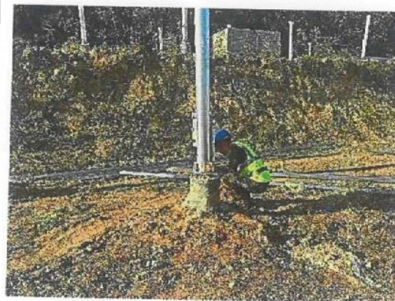
洪池地块立柱校正调平
