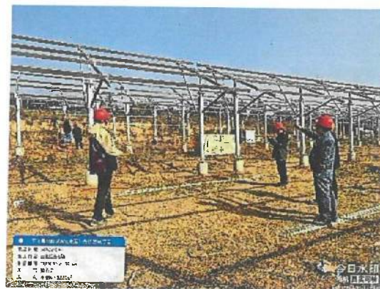
业主领导洪池现场巡视检查
