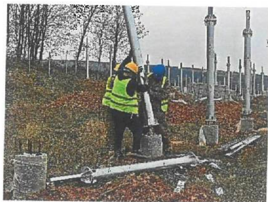
洪池地块立柱安装
