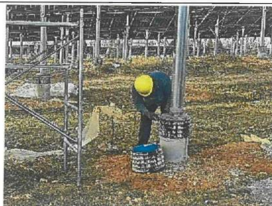
洪池地块桩基础二次浇筑拆模
