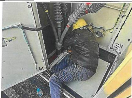
洪池地块高压电缆防火封堵
