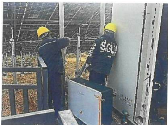
洪池地块能量管理单元安装
