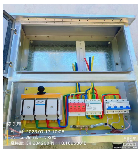
监理现场检查
