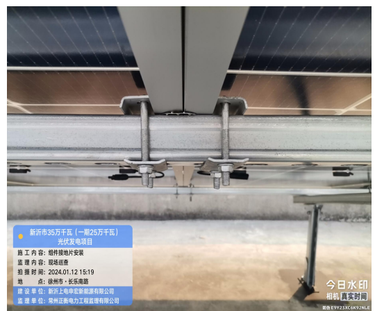
接地穿刺片安装
