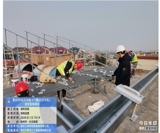
接地穿刺片安装
