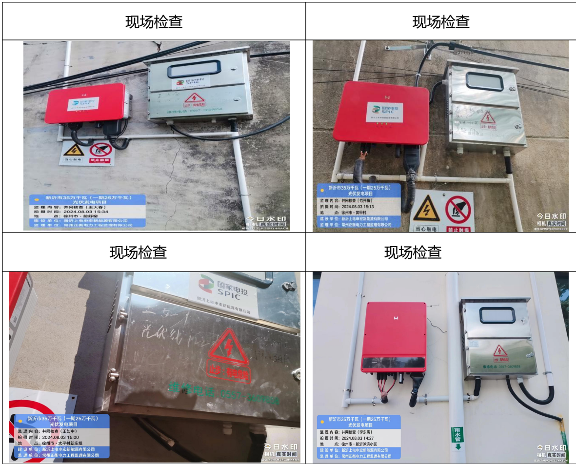
工程现场照片：（安装支架、组件、逆变器、搭网图片各一张）
