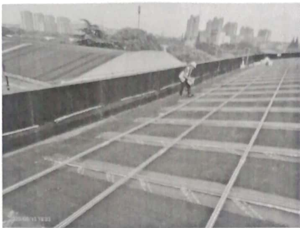
配件二库导轨安装
