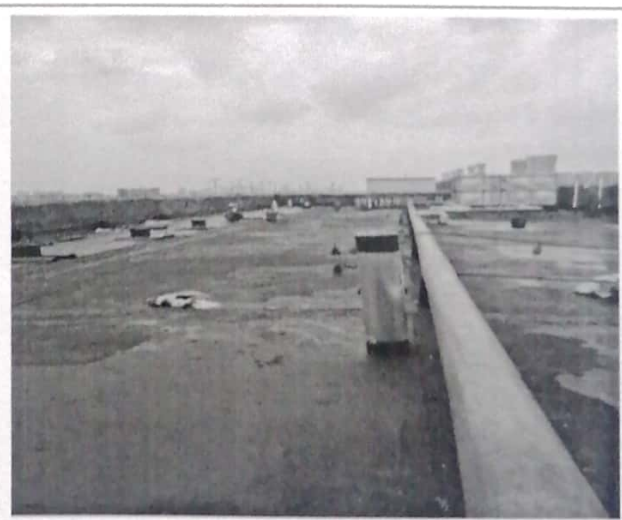
南厂综合楼防水作业
