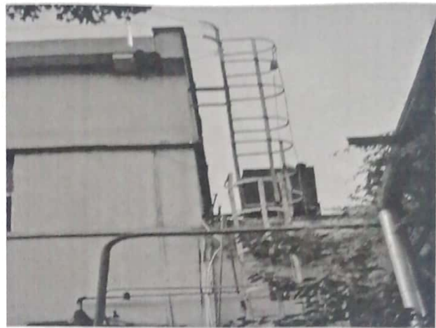
配件联合厂房直爬梯防坠器挂设
