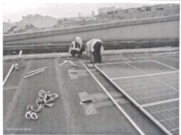
二联扁铁安装
