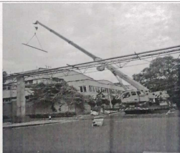
配件制造中心吊装地梁
