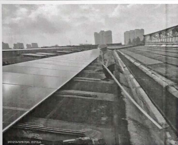
配件联合厂房接地安装
