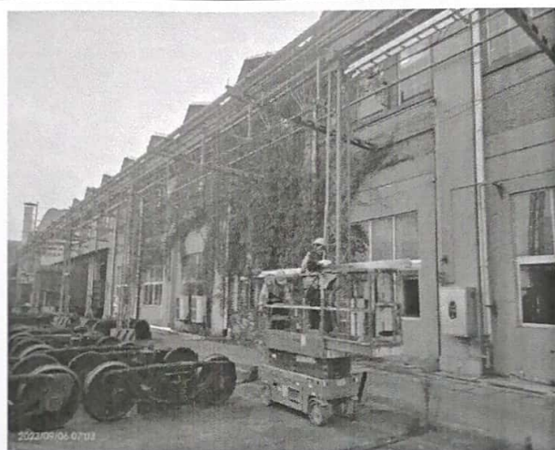
南厂高压电缆桥架安装
