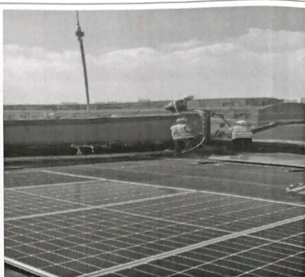
交流电缆敷设
