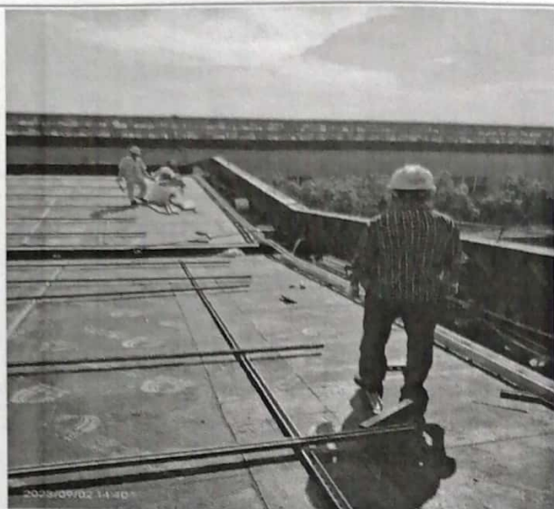
木工厂房桥架安装
