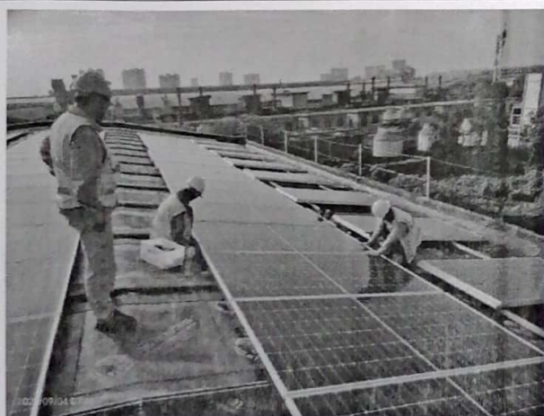
柴油机库组件安装
