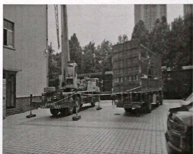
车辆办公楼支架吊装
