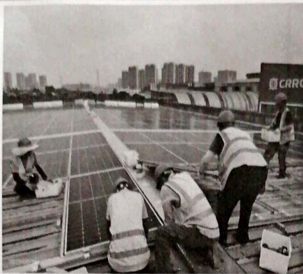
配件一库组件安装（BIPV）
