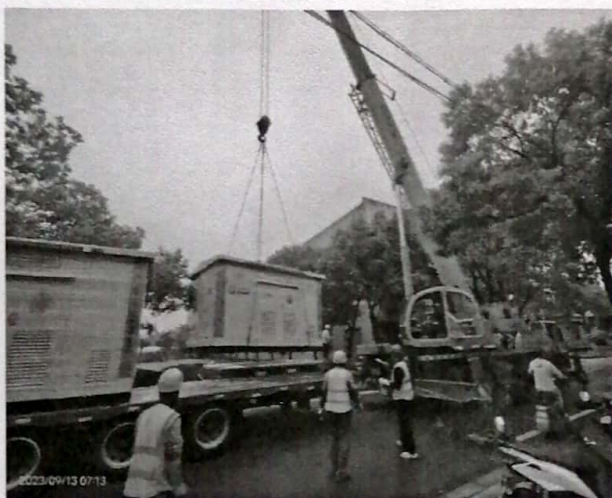
箱式变压器吊装
