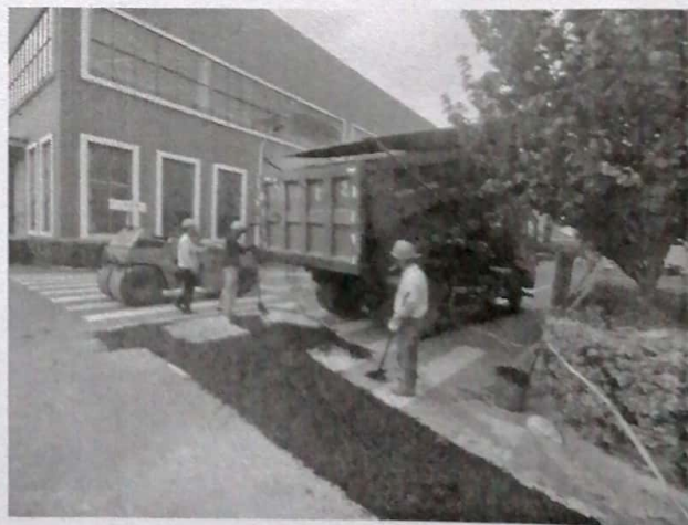
路面沥青修复
