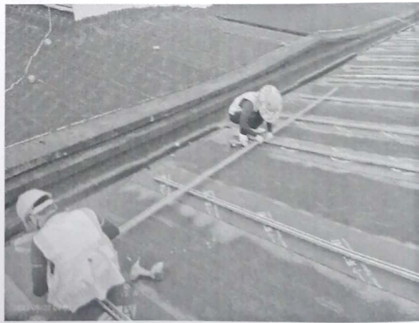
西栈桥导轨安装
