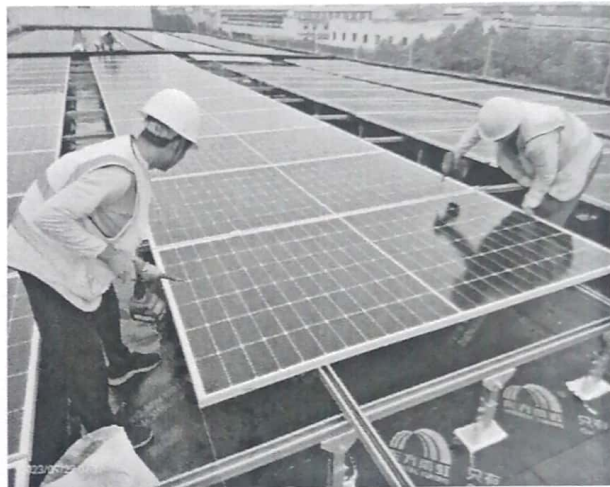
车辆办公楼组件安装
