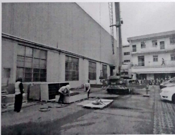
西栈桥组件吊装
