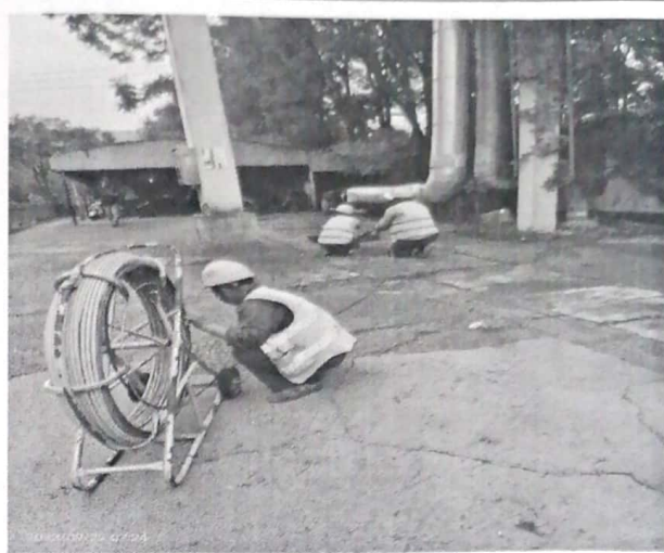
高压电缆敷设
