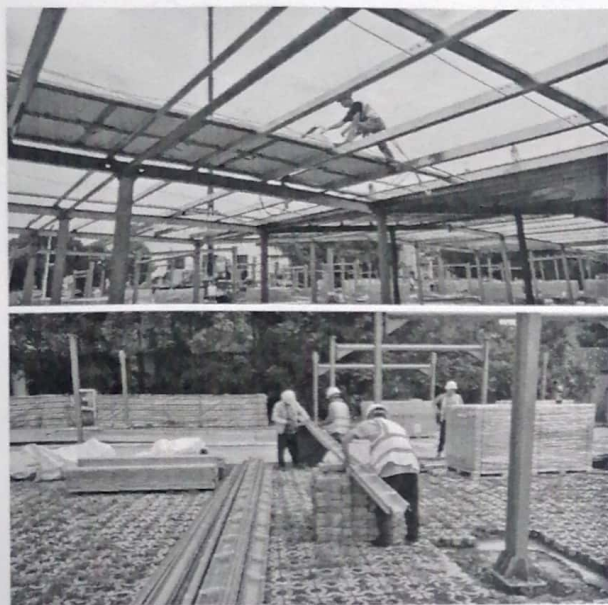
北厂车棚组件安装
