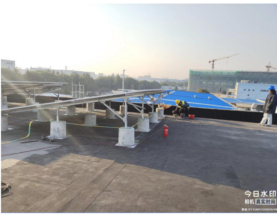
接地扁铁焊接
