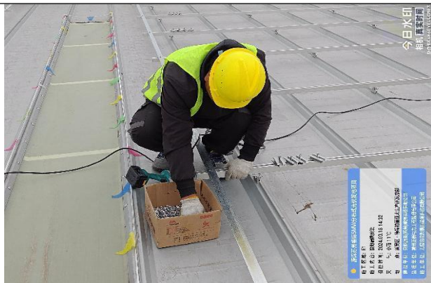
A1组件安装及接地线安装
