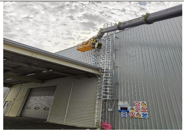
E1、E2下墙桥架安装
