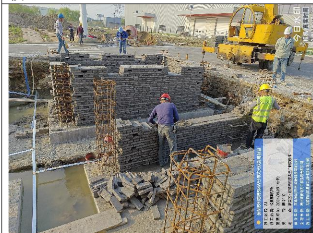
设备基础砌砖、构造柱、圈梁钢筋绑扎及支模
