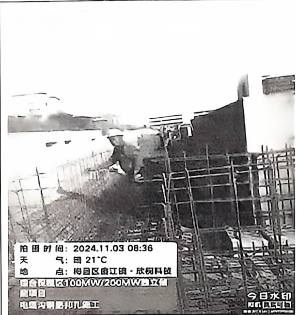
电缆沟绑扎钢筋施工。
