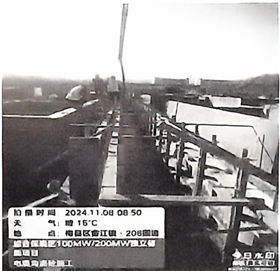
电缆沟浇筑施工
