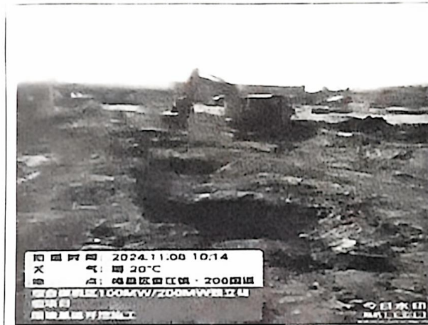
电缆沟支架加工、围墙基础开挖施工
