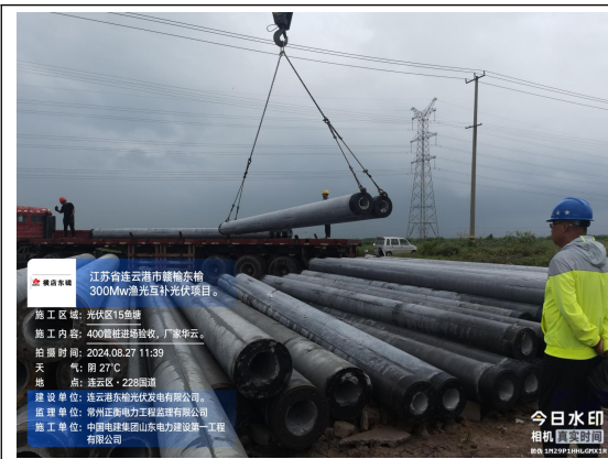
现场管桩材料进场
