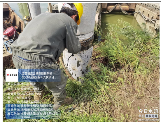
对管桩焊接进行检查
