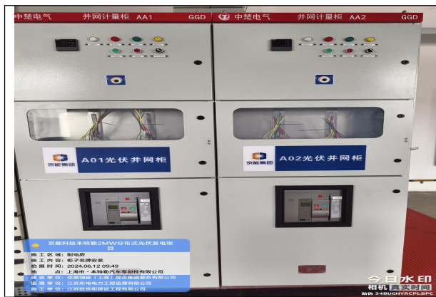
江苏东电电力工程监理有限公司 京能科技本特勒2MW分布式光伏发电项目监理项目部 2024年06月14日
