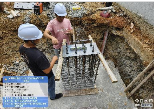
4号车棚基础预埋螺栓检查
