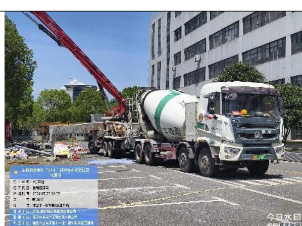
4号车棚基础短柱浇筑
