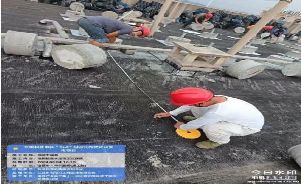
水泥墩定位摆放
