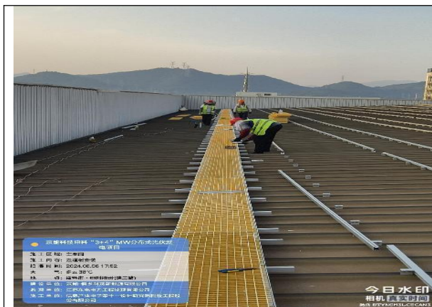
水泥屋面垃圾清理
