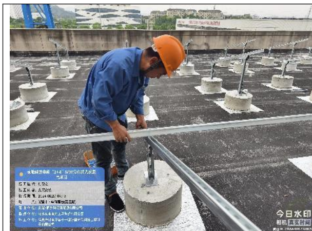
逆变器支架安装
