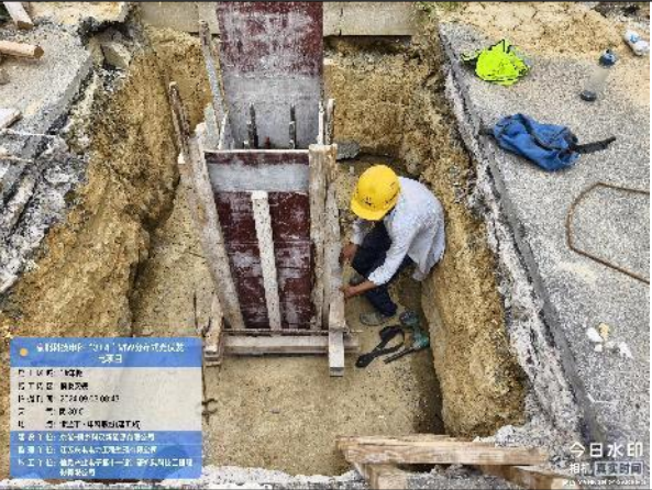
2#车棚基础回填
