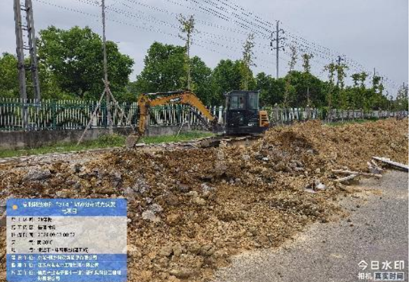
2#车棚基础回填
