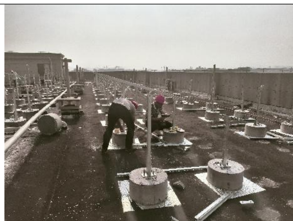
1#车棚基础短柱检查
