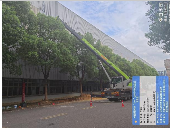
主车间下墙桥架安装
