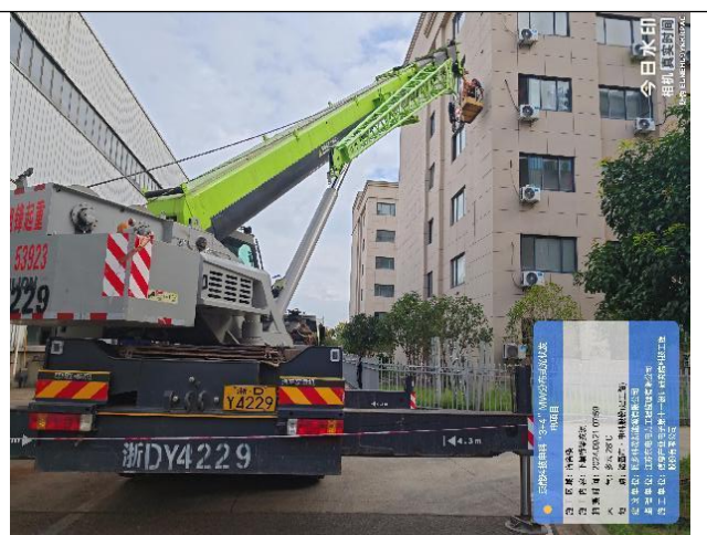
主车间组件安装
