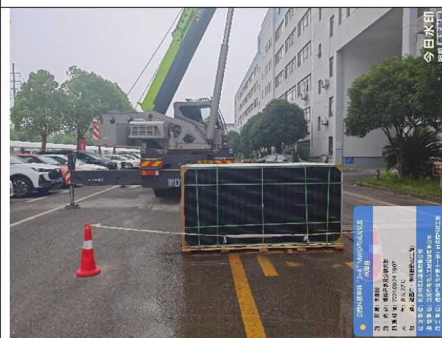
4#车棚组件安装
