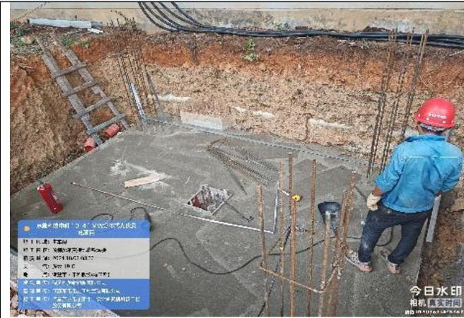
主车间预制舱箱变基础底板钢筋检查
