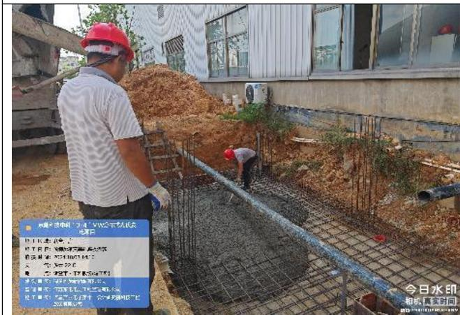
联合厂房预制舱箱变基础底板浇筑
