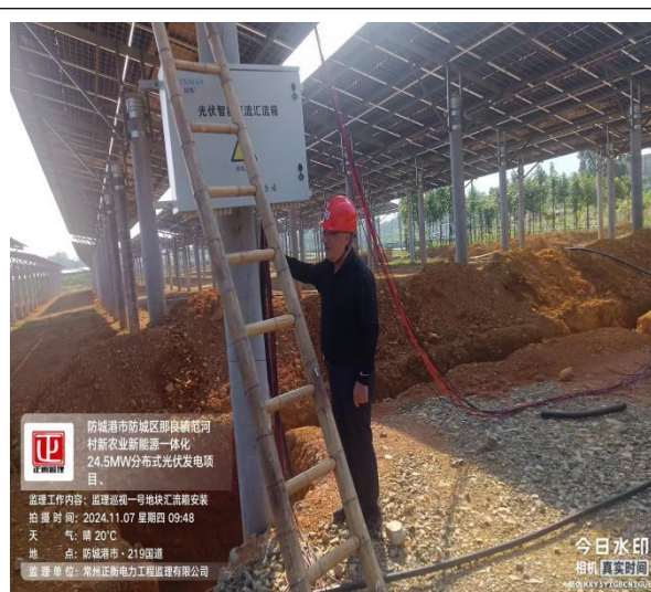
监理检查汇流箱安装
