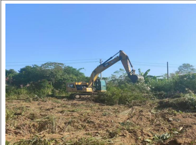
监理巡查四号地块平整场地
