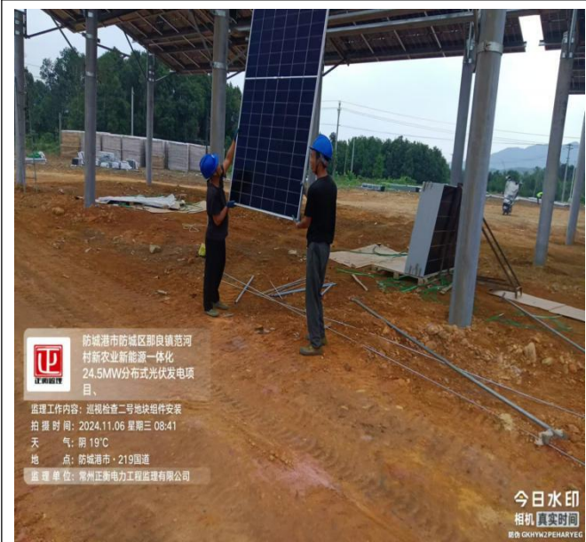
监理巡查组件施工
