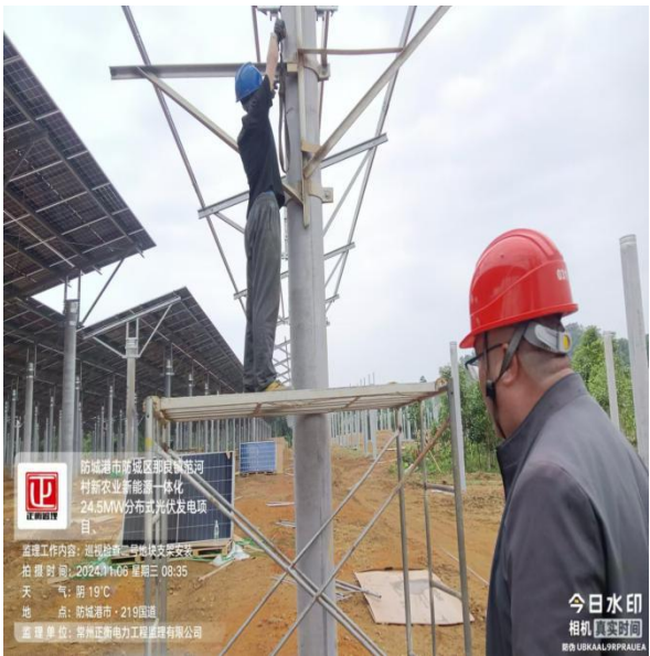
监理巡查支架施工
