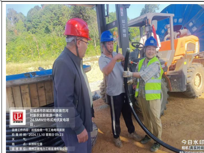
监理检查电缆敷设
