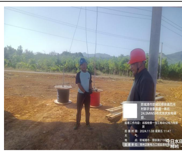
监理巡查 4m2 电力直流线敷设
