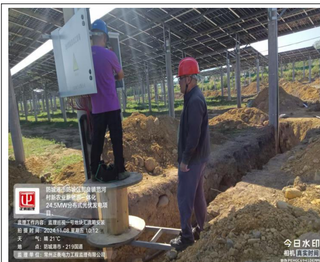
监理检查汇流箱安装
