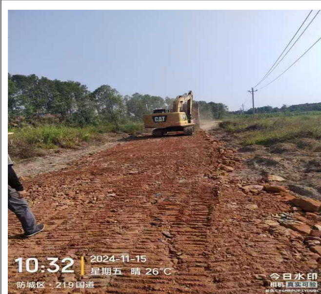
监理巡查四号地块平整场地
