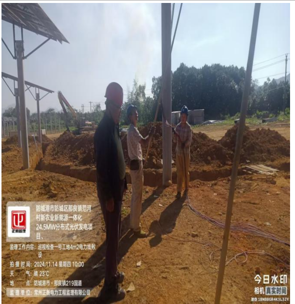
监理巡查 4m2 电力直流线敷设
