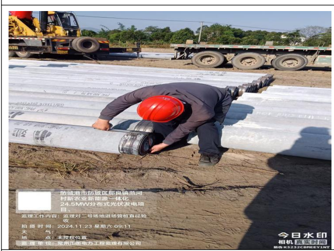
监理检查管桩直径
