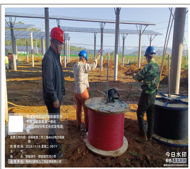
监理巡查二号地块 4m2 直流线敷设
