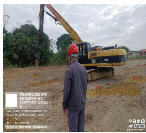
监理巡查管桩引孔
