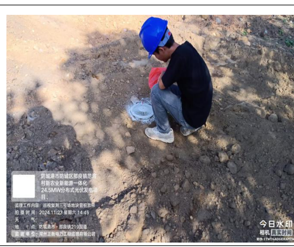
监理检查管桩放样
