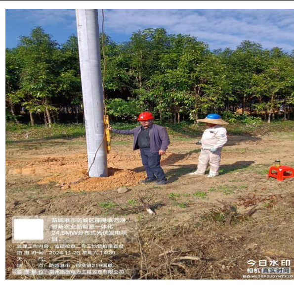
监理检查管桩垂直度
