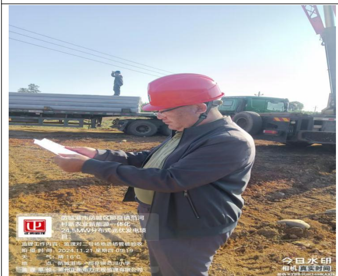
监理检查管桩合格证
