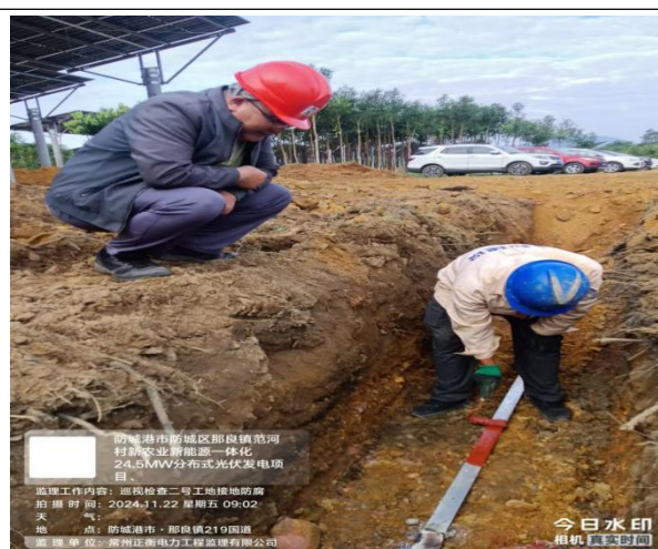
监理检查接地防腐
