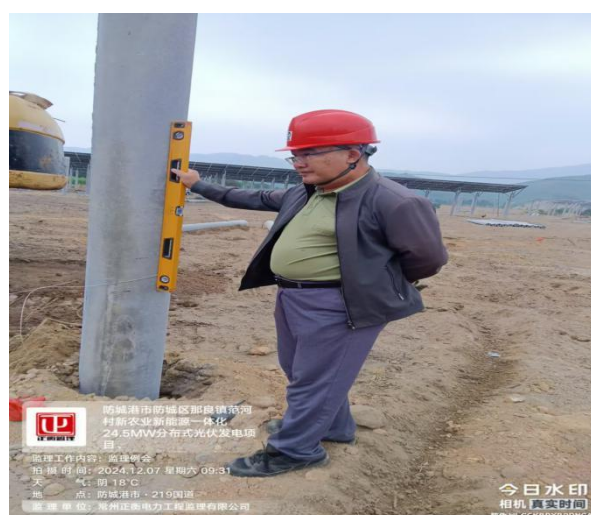
监理检查管桩垂直度
