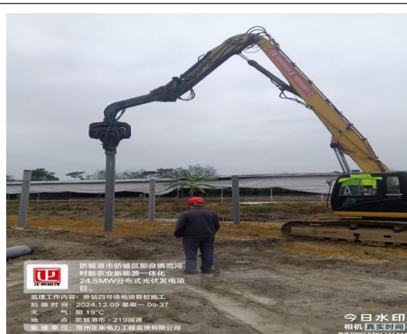
监理旁站管桩施工
