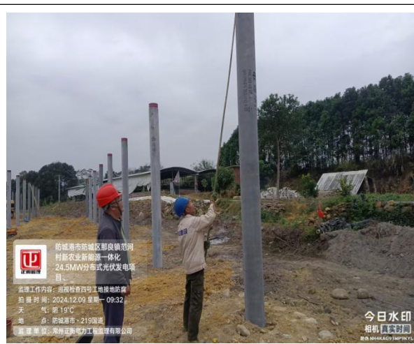
监理巡查管桩端板防腐
