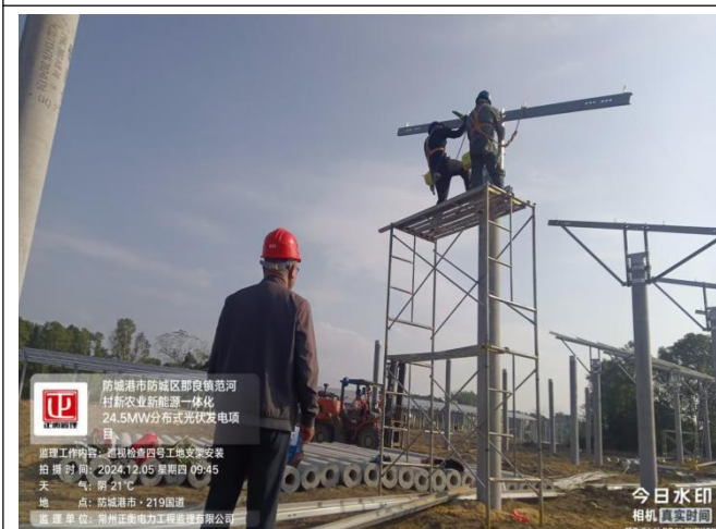
监理巡查支架施工
