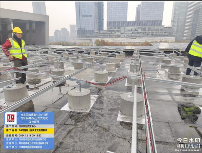
混凝土屋面直流电缆敷设
