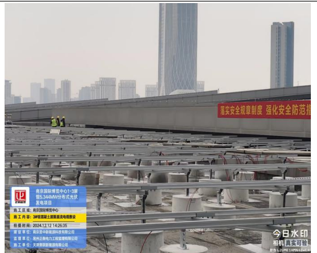
直流电缆敷设
