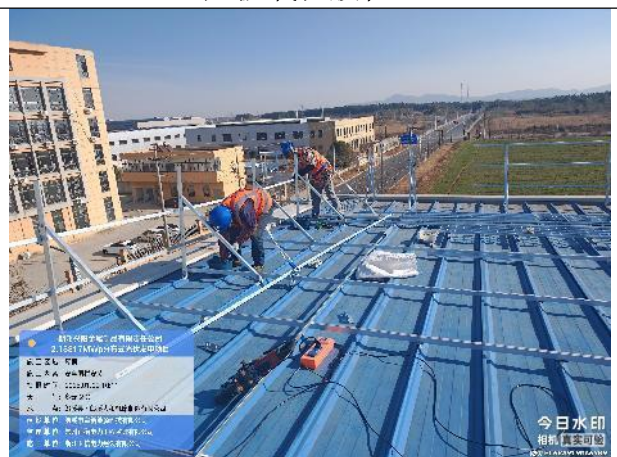
安全围栏安装
