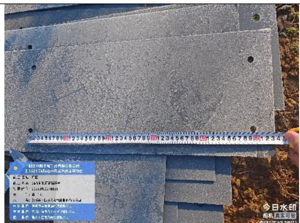
2#车间加固材料检查
