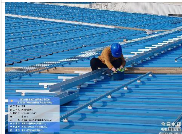
直流桥架安装
