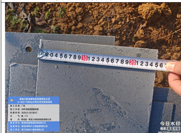
2#车间加固材料检查
