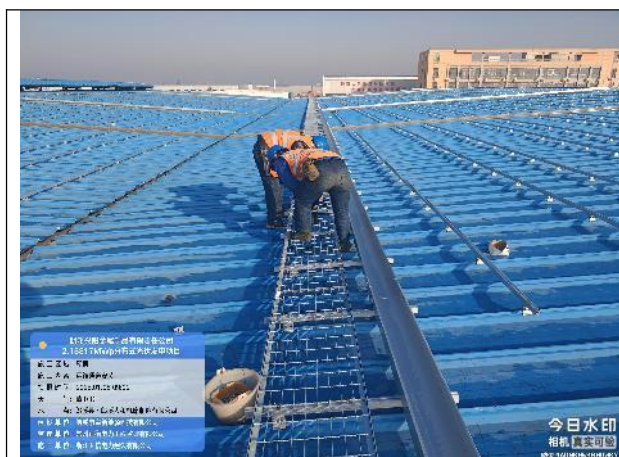
运维通道安装
