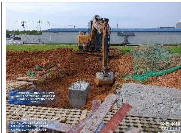
车棚钢结构材料进场
