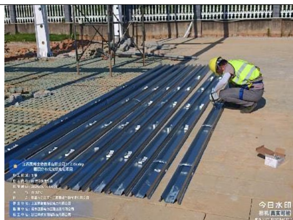
车棚钢结构安装及组件安装
