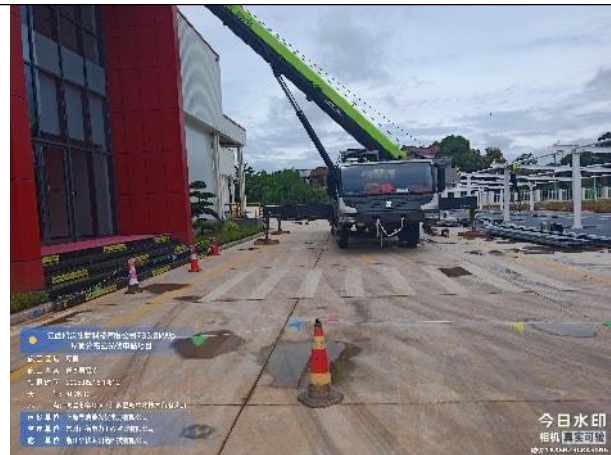
交流电缆敷设
