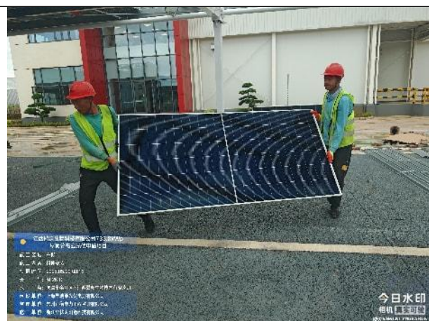
车棚钢结构安装
