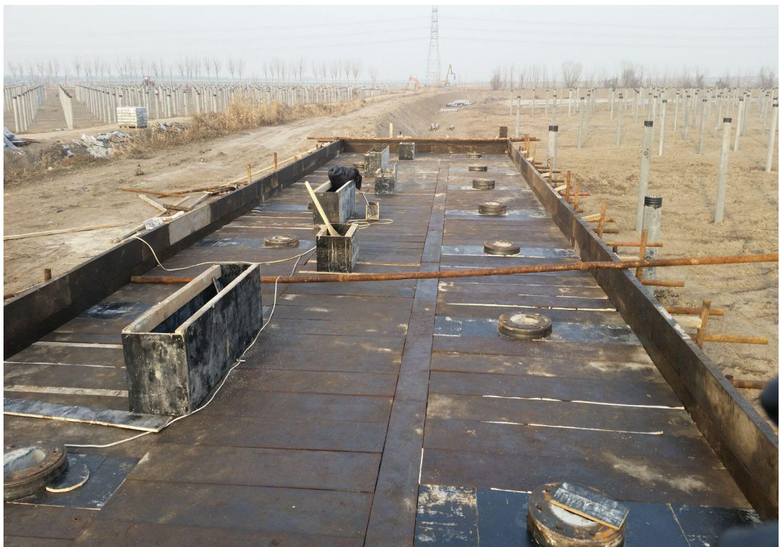
2、箱变平台支模板
