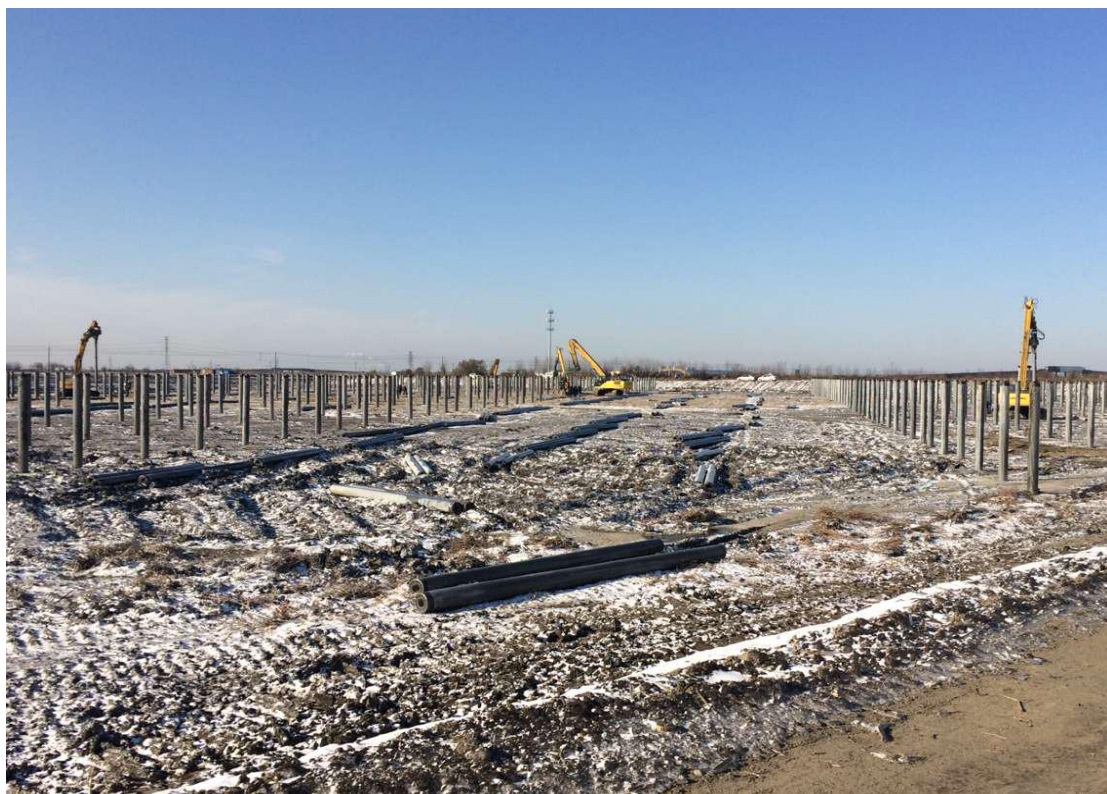
3、池塘打桩施工
