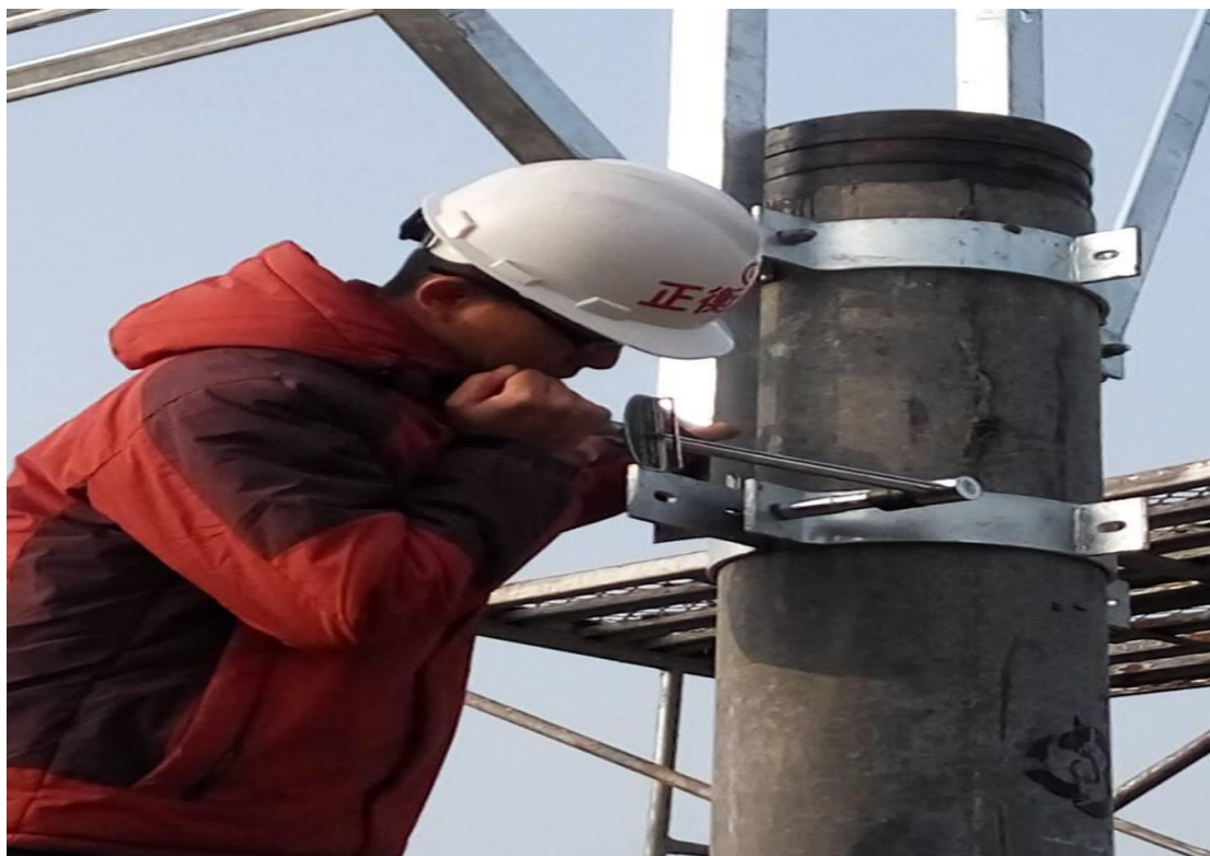
5、支架螺丝紧固检查
