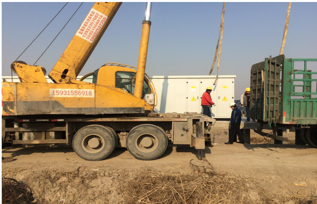
1、箱变吊装旁站
