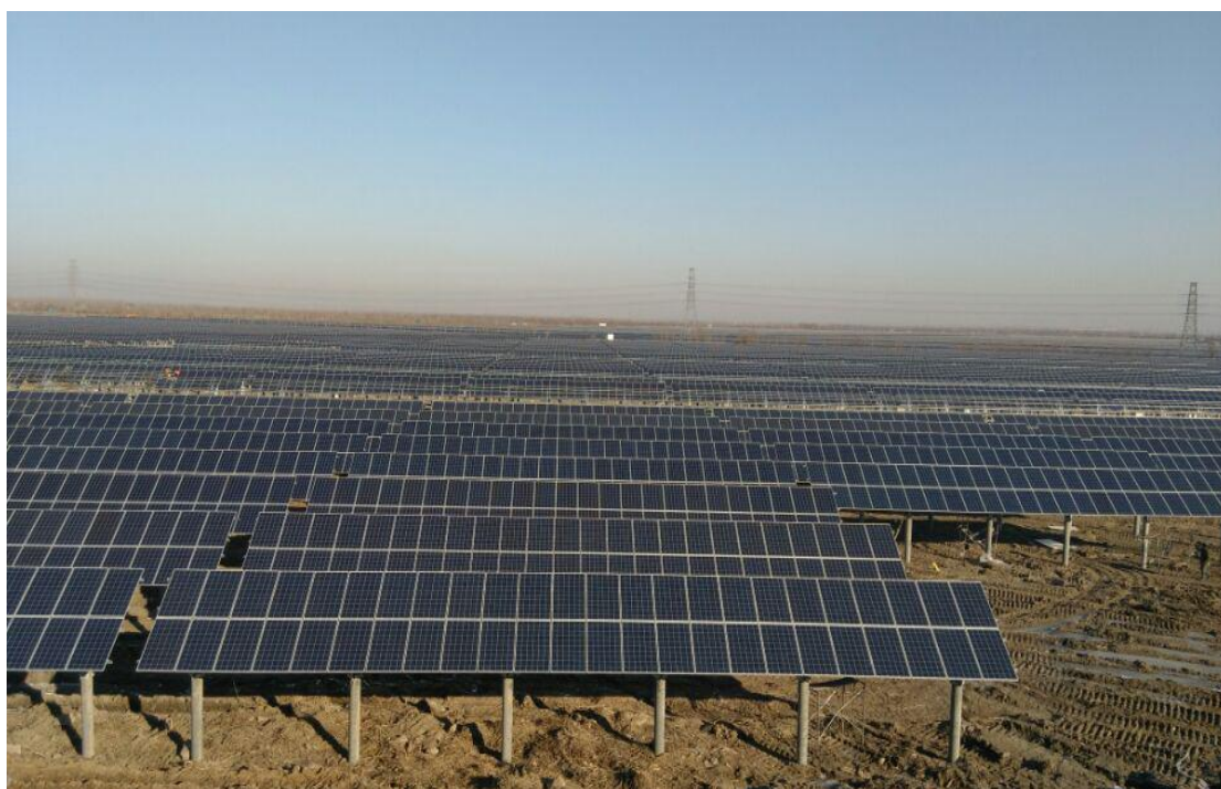
2、已安装完成局部区域组件
