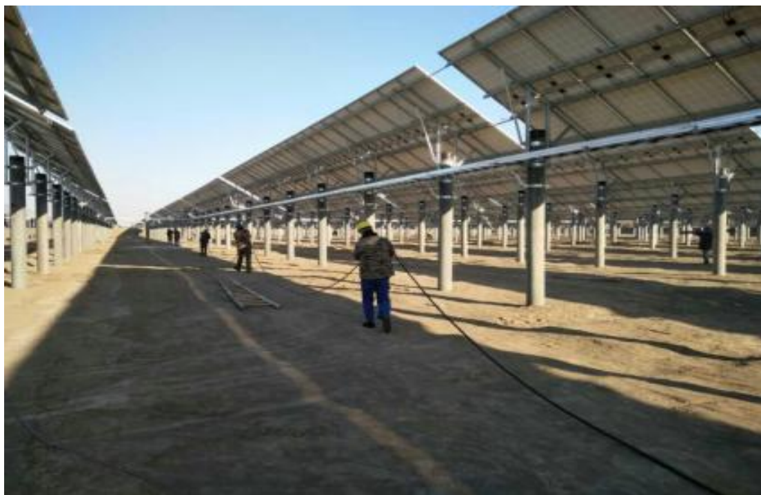
3、28#池塘 3*50 电缆敷设
