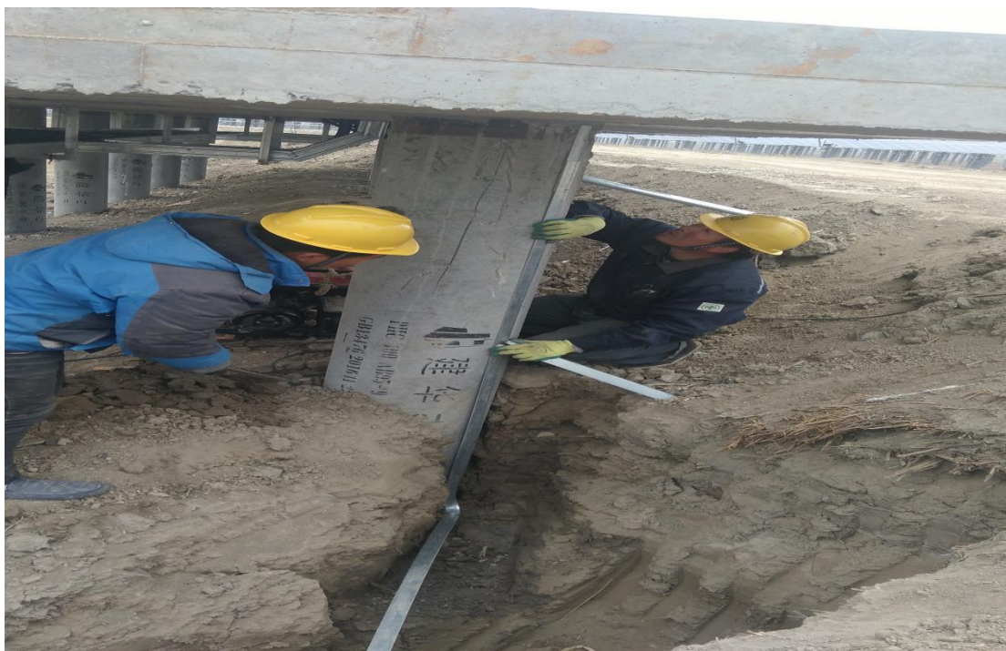
4、箱变平台基础扁铁与接地极焊接
