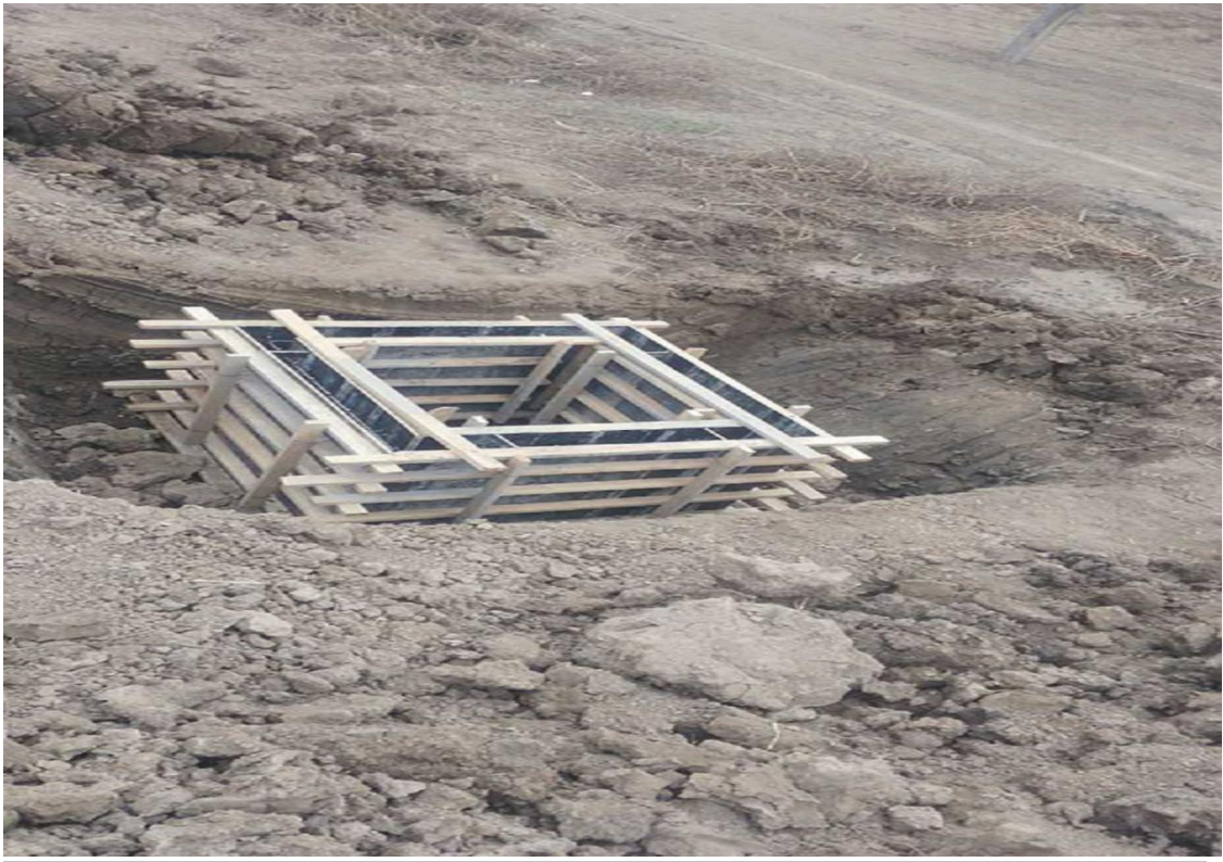
1、给排水系统模板安装
