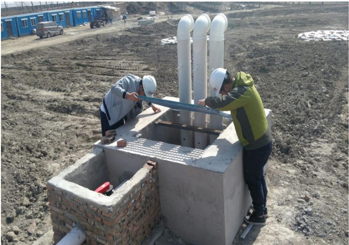
2、查看插管井管道安装
