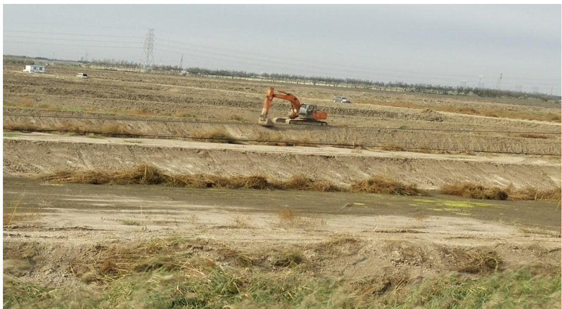
池塘边坡修整
