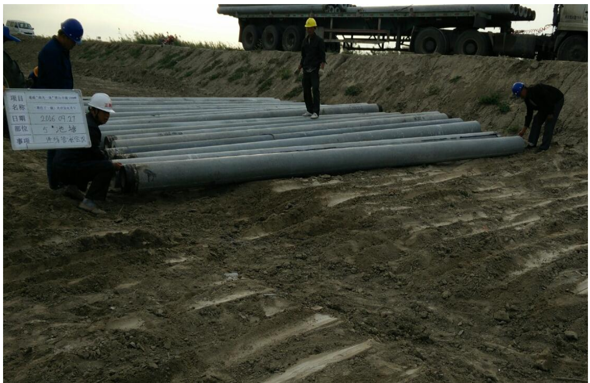
进场管桩验收
