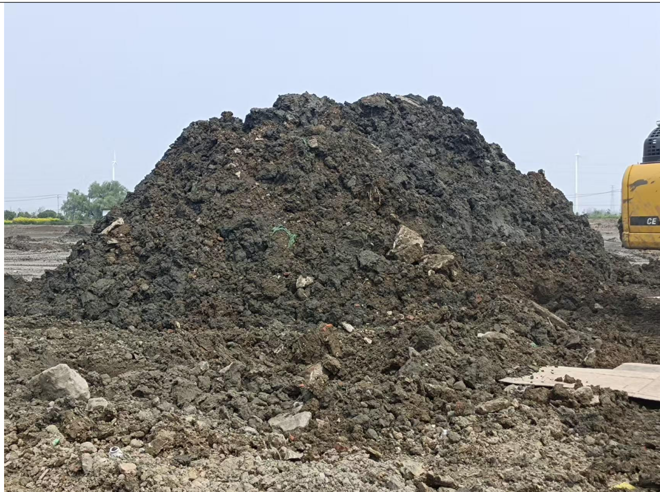
回填土里面夹杂砖头、混凝土块等建筑垃圾
