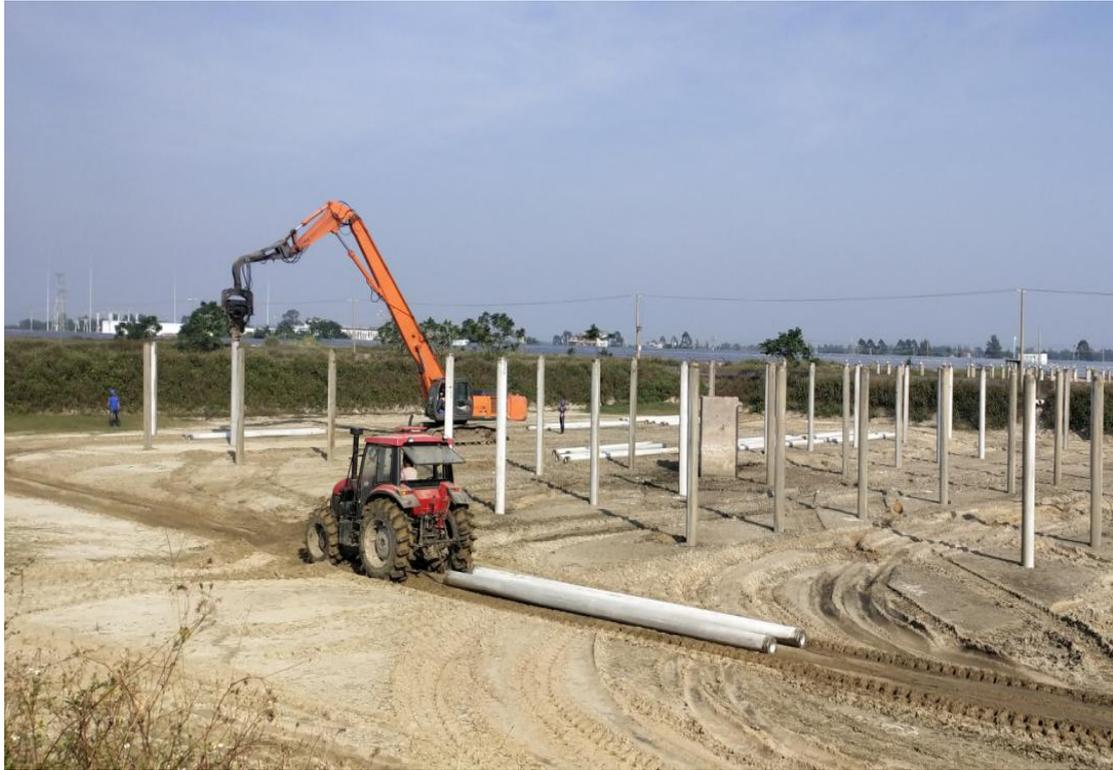
(2) 鱼塘和环沟打桩时打桩机和挖掘机需要进入塘底和沟底进行施工，后续支架组件安装时装载机转运材料也需要进入塘底，由于塘埂和沟堤高差都超过 2 米以上。故而在重型机械进出时必定会对塘埂、沟堤造成损坏。我公司为降低对塘埂和沟堤的损坏，会根据每个塘埂和沟堤的实际情况进行规划路线，对部分塘埂开口，以便施工。从而保护塘埂和沟堤，当施工完毕后我公司会按原状标准重新恢复塘埂和沟堤。
