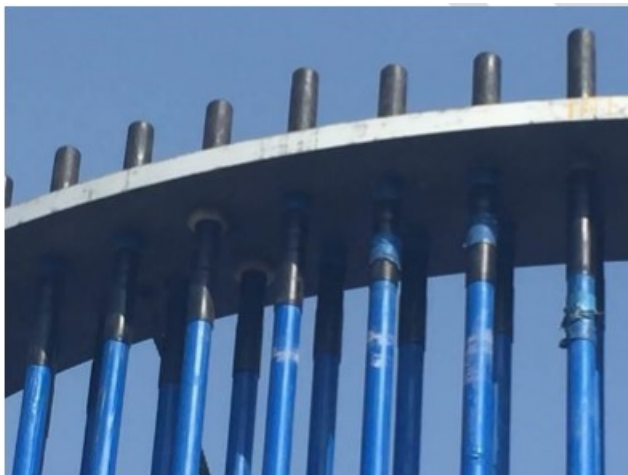
图 3.32 锚栓上端套螺纹护套
