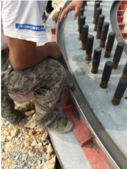
图 4.5 二次灌浆施工
