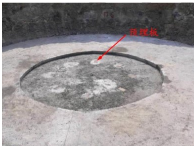
图 3.2 混凝土垫层中的预埋件
