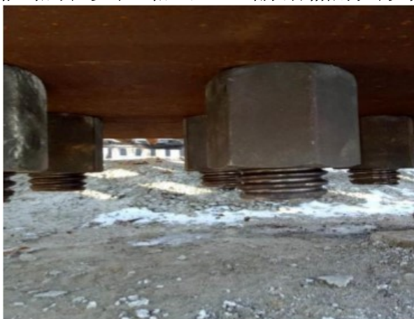
图 3.34 锚栓下端螺母外露丝扣
