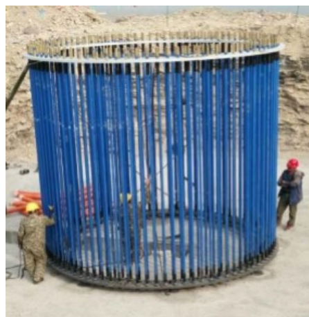
图 3.35 安装成型的锚栓笼
