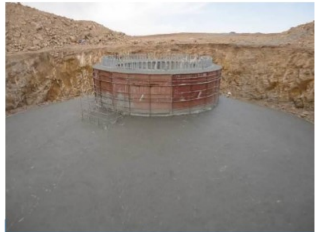
图 4.4 混凝土浇筑（2）
