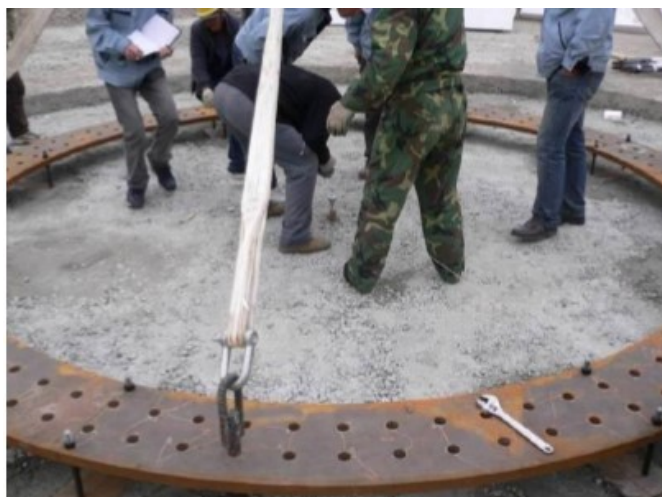
图 3.8 下锚板与基础的同心度调整图
