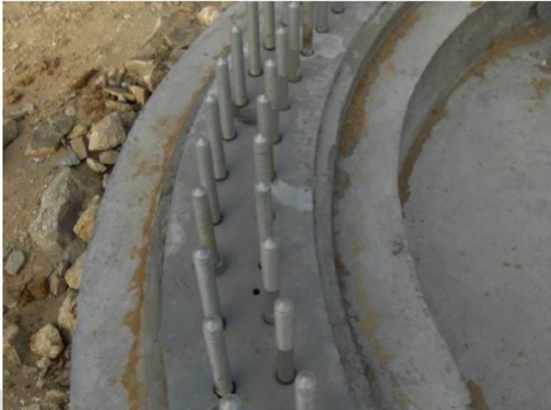
图 4.6 成型后的灌浆层
