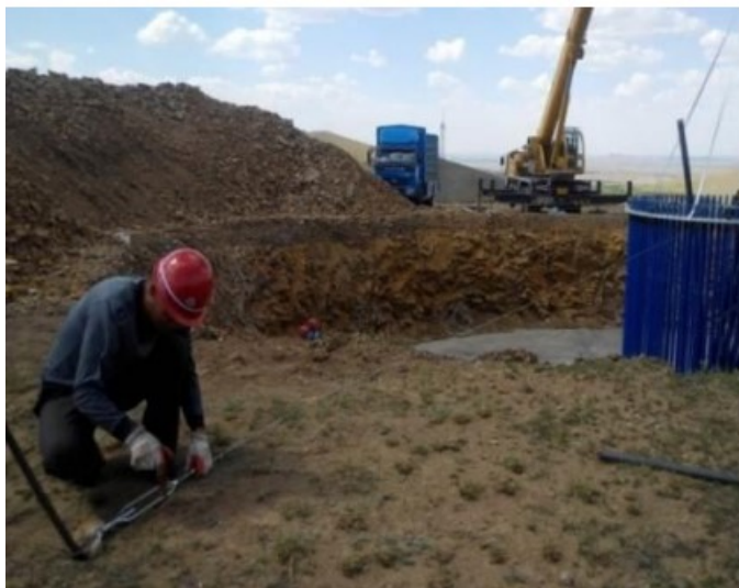
图 3.25 基坑外缘设置锚点
