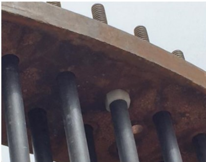
图 3.28 尼龙螺母贴合上锚板下表面
