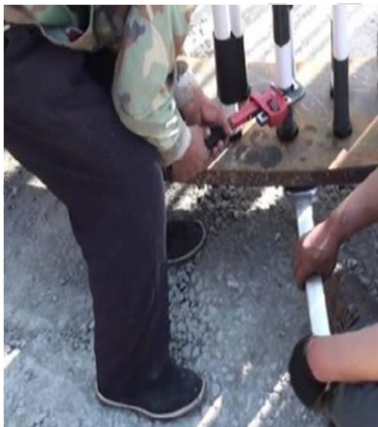
图 3.30 锚栓下端螺母拧紧
