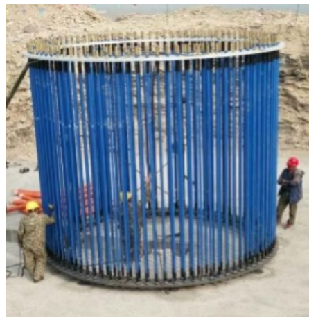
图 3.35 安装成型的锚栓笼
