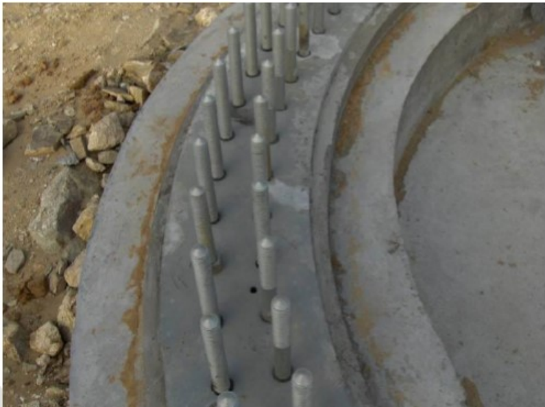
图 4.6 成型后的灌浆层
