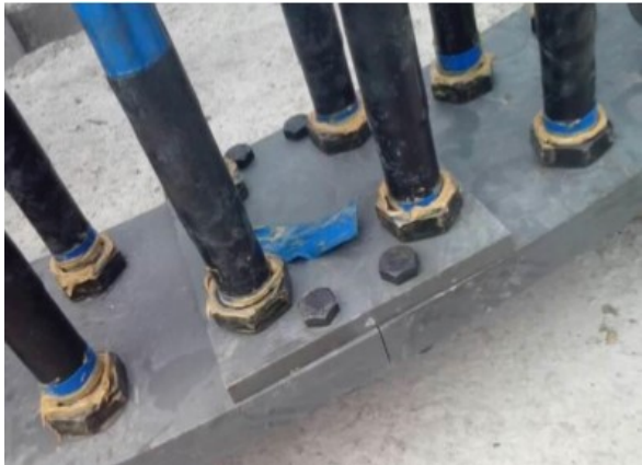
3.17 下锚板连接板处的锚栓
