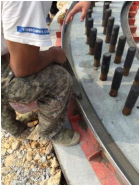
图 4.5 二次灌浆施工
