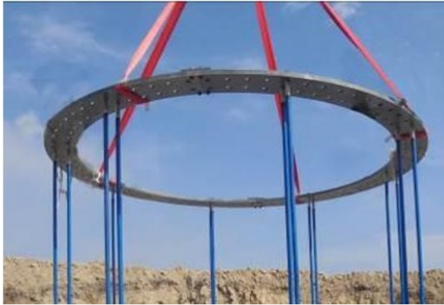
图 3.20 定位锚栓安装
